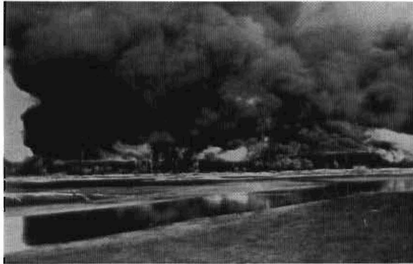
Les scieries et leurs installations devenant la proie des flammes.
